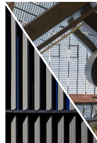
FOTOWOLTAIKA ZINTEGROWANA Z BUDOWNICTWEM ORAZ SZYBY AKTYWNE
