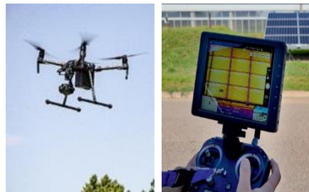
Fot. 30 Termowizyjny przegląd dronem instalacji PV
