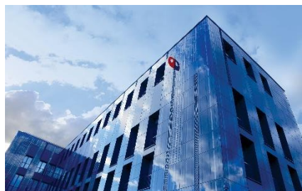
Fot. 6 Fasada wentylowana
