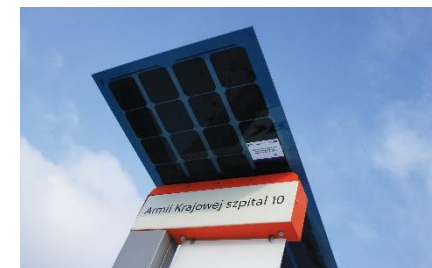
Fot. 12 Smart Pylon
