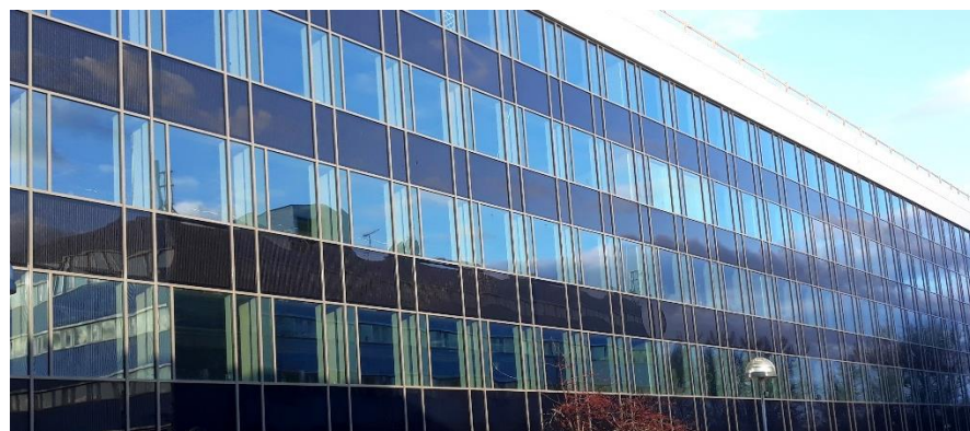
Fot. 61 Fasada słupowo ryglowa z elementami fotowoltaicznymi, budynek administracyjny, Szwecja
