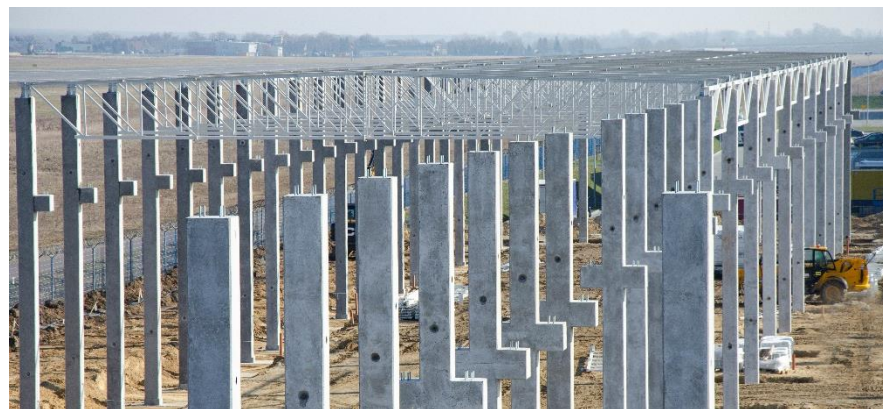
Fot. 80 Budowa nowej Hali
