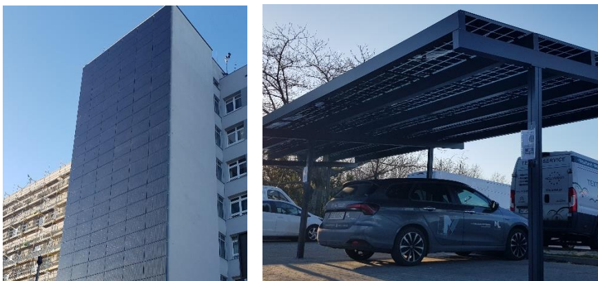
Fot. 49 Instalacje fotowoltaiczne Szpital Wojewódzki w Poznaniu
