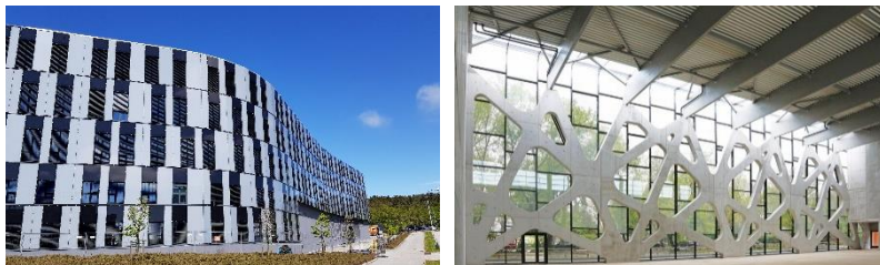
Fot. 11 Fasady fotowoltaiczne – realizacje ML System
