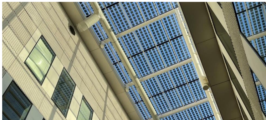
Fot. 53 Siedziba Shell w Holandii, świetlik fotowoltaiczny z wykorzystaniem modułów BIPV
