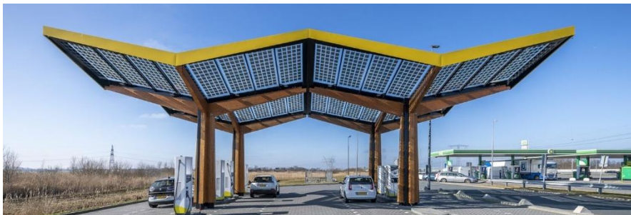
Fot. 51 Stacja ładowania pojazdów, Holandia, źródło: https://hermanstechnisolar.com/projects/fastned-europe/
