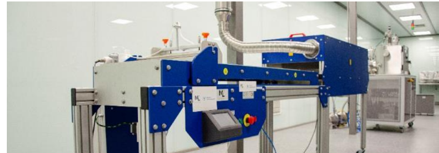
Fot. 68 Element linii do produkcji fotowoltaicznego ogniwa tandemowego
