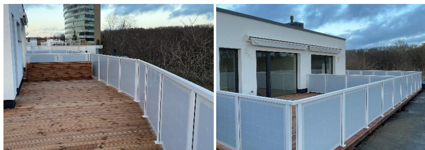
Fot. 54 Białe balustrady BIPV wielomieszkaniowego budynku w Estonii
