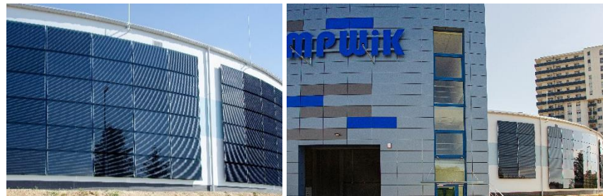
Fot. 57 Fasada wentylowana zamontowana na nowym zbiorniku wody pitnej w Rzeszowie
