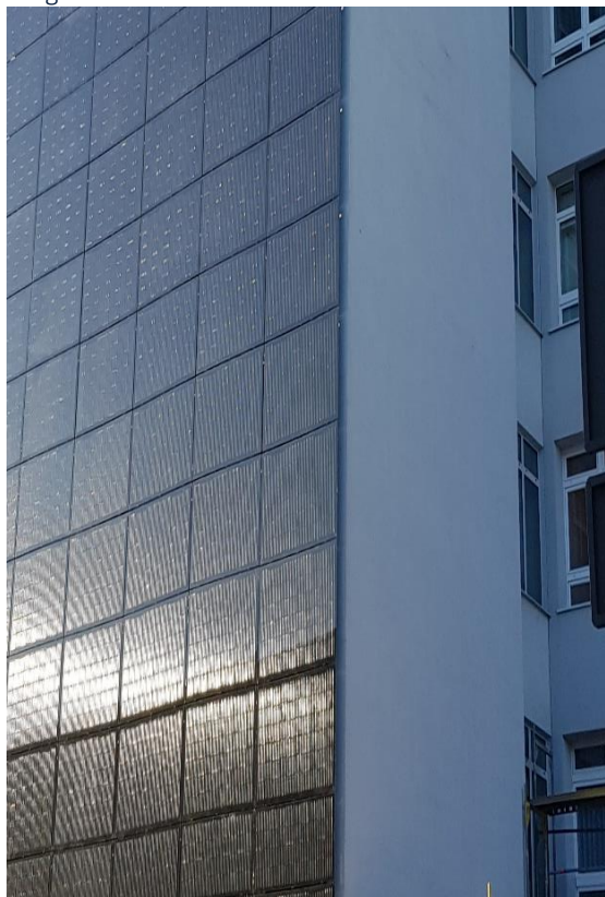
Szpital wojewódzki Juraszów, Poznań Fasada fotowoltaiczna, Carport, Instalacja dachowa i gruntowa
