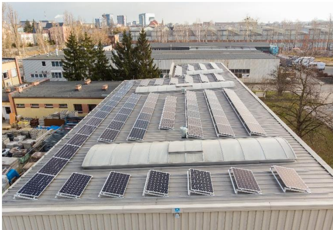
Hala magazynowa, Wrocławski Park Przemysłowy (Wrocław)
