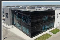
Fotowoltaiczna fasada wentylowana
